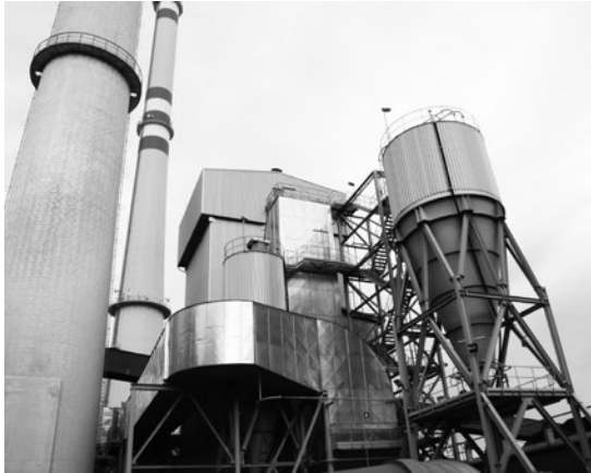
Odsírenie spalín : Uvedenie do prevádzky v roku 2011, technológia NID, stupeň odsírenia min. 75 %, emisie TZL pod 30 mg.m -3 , zníženie emisií SO 2 o cca 900t/rok.
