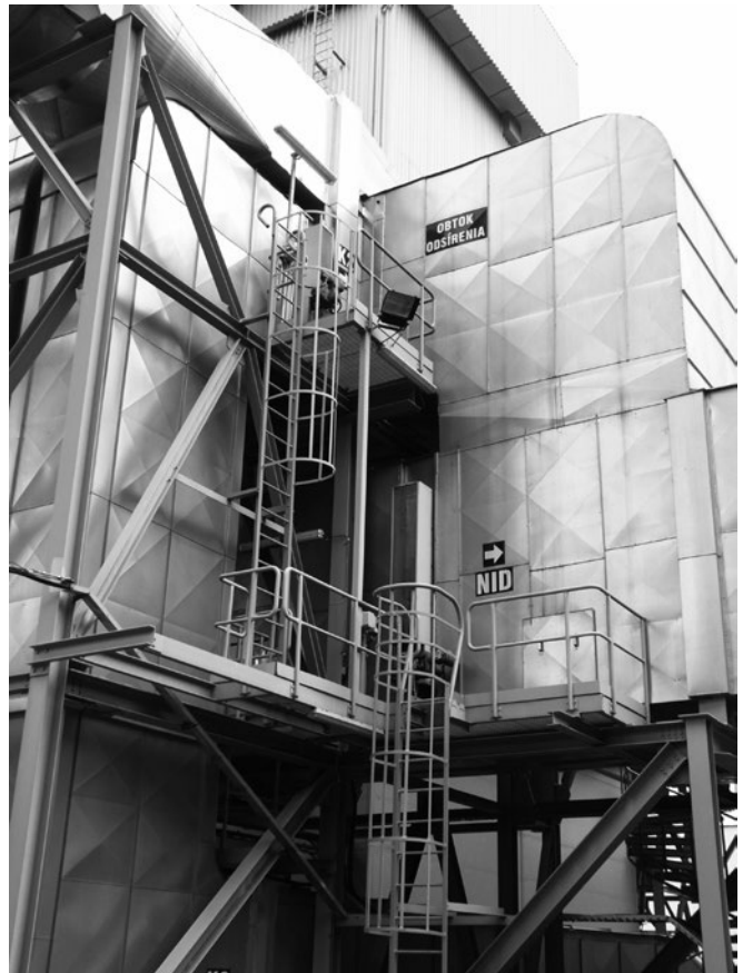
Odsírenie spalín : Uvedenie do prevádzky v roku 2011, technológia NID, stupeň odsírenia min. 75 %, emisie TZL pod 30 mg.m -3 , zníženie emisií SO 2 o cca 900t/rok.
